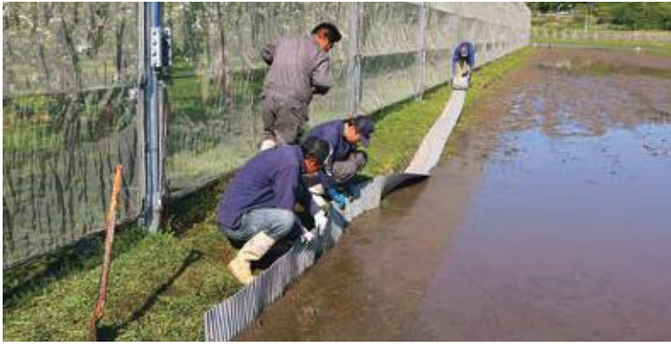
協力して力強く波板を差し込む部員ら
